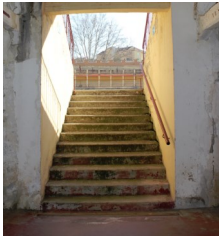
Escaleras de acceso
