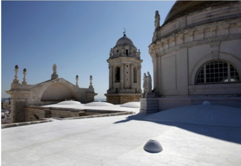
Imagen de la catedral de Cádiz con un mortero que incorpora nanomateriales de carbono
