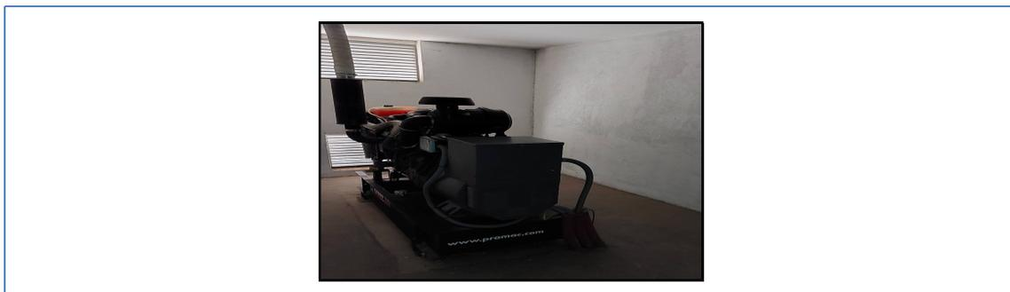
El grupo electrógeno dispone de un depósito propio y de ventilación de humos conducido al exterior. Abastece<sup>(1)</sup> a parte de la iluminación, y a las bombas contra incendios.
